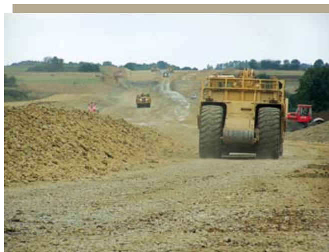
Chantier du contournement de Moiry
