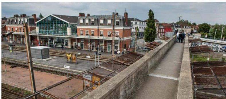
Le pôle gare de Béthune
