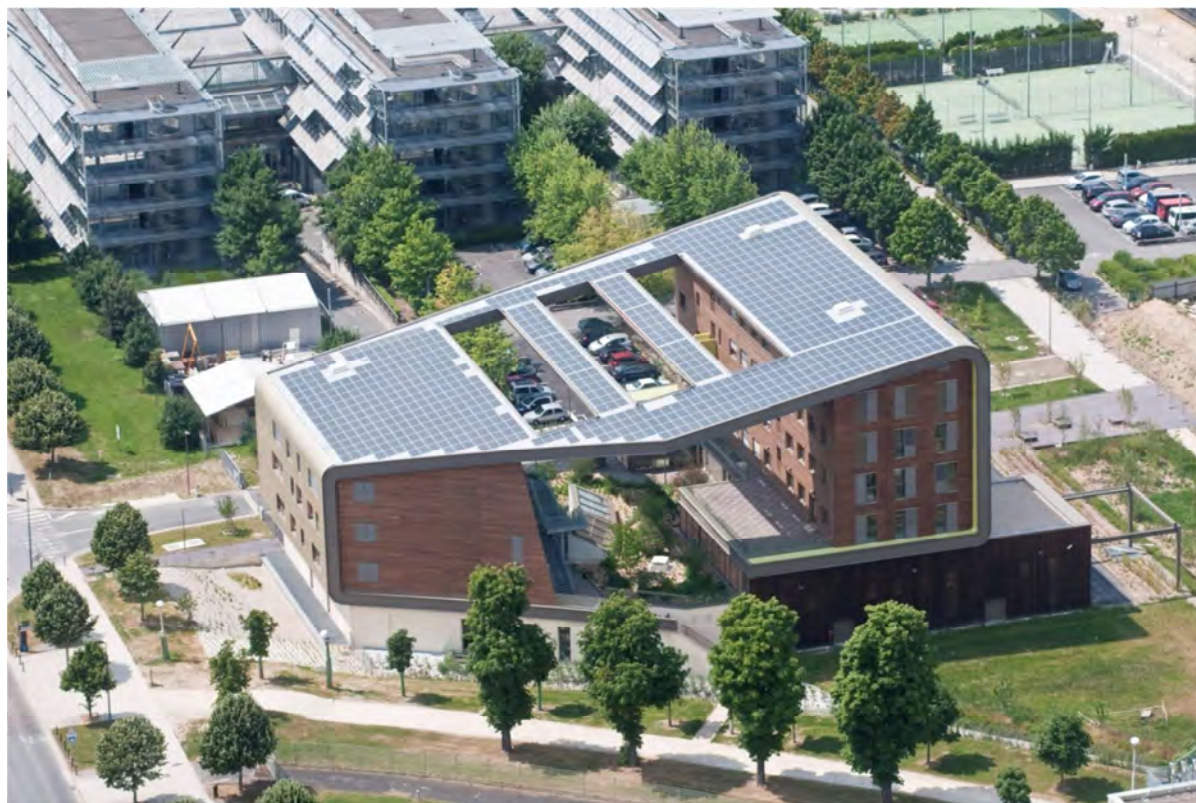
Figure 7: Vue aérienne sur le Bâtiment Descartes+, bâtiment à énergie positive, Source EPAMARNE
