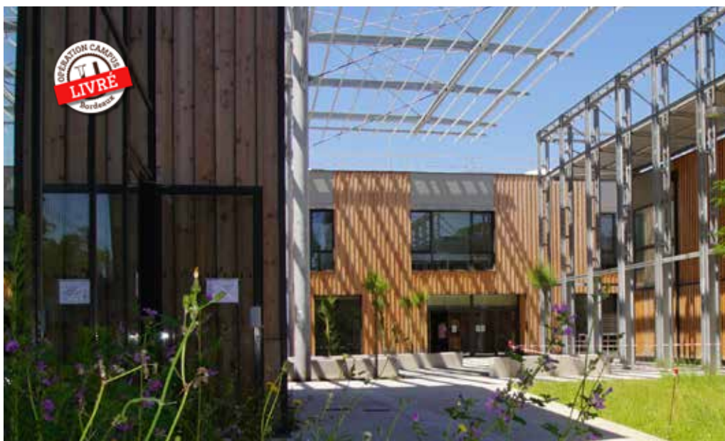
Placette du bâtiment A9 ©Antoine Billaud
