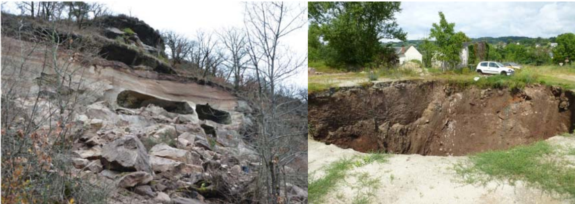
Figure 29 : Blocs en pied de falaise de grès et sur le glacis (source BRGM janvier 2016) - Effondrement d'anciennes ardoisères (source BRGM juillet 2014)
