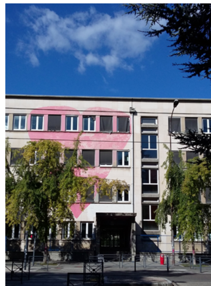
6,97 M€ DE FRANCE RELANCE POUR LA DÉMOLITION ET LA RECONSTRUCTION COMPLÈTE DU LYCÉE EMMANUEL MOUNIER - GRENOBLE (38)
