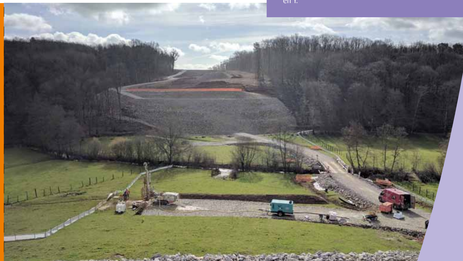
Travaux de fondations du viaduc de la Scyotte
