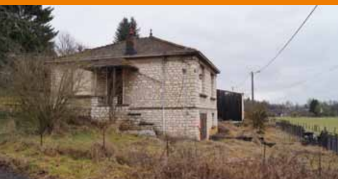
Maison à démolir (rue de Rémaucourt)
