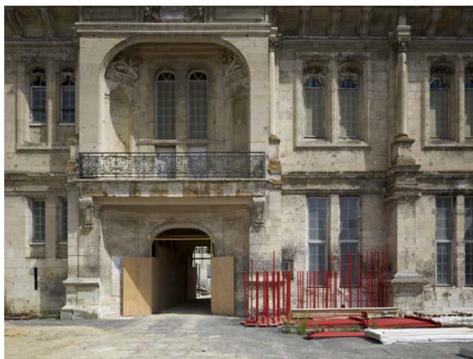
Château de Villers-Cotterêts, façade du corps de logis, mise en place du chantier © Pierre-Olivier Deschamps – Agence Vu' / Centre des monuments nationaux
