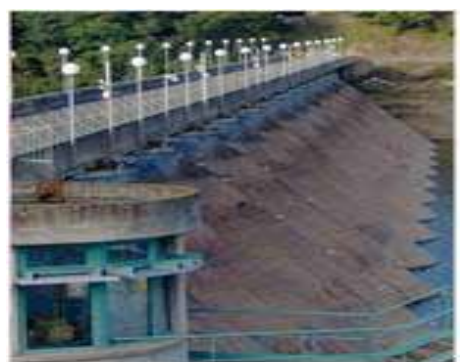
Revêtement de barrages
