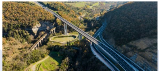
Viaduc du Chabassot pour le contournement du Teil en Ardèche
