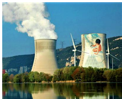
Photo n°3. Tour nord de la centrale EDF de Cruas-Meysses
