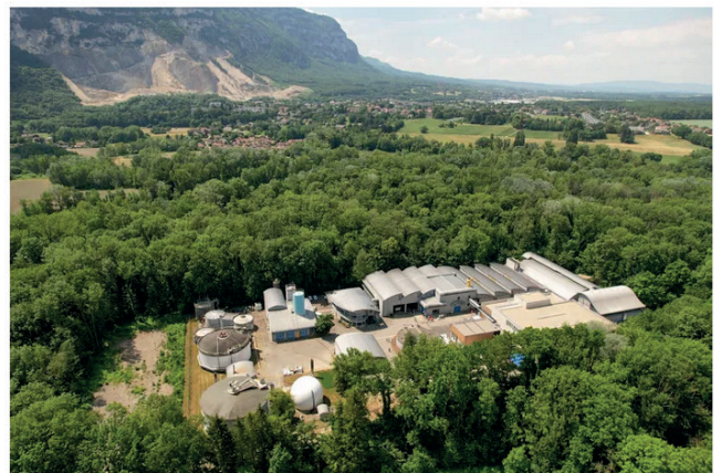
Vue de la STEP d'Ocybèle © Annemasse Agglo
