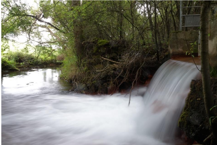
Figure 12 - Galerie de débordement du réservoir centre à Mancieulles, ancienne mine de fer
