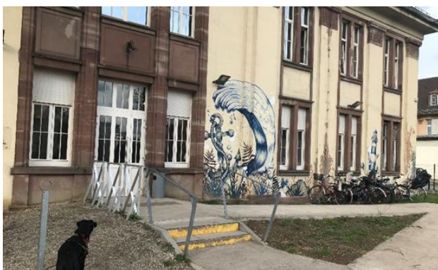
Figure 5 : entrée avant Argos 1 HSA
