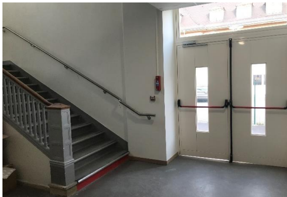
Figure 13 : escalier extérieur hébergement
