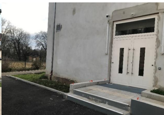
Figure 6 : entrée latérale Argos 2 hébergement
