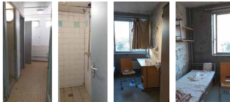
Intérieurs actuels des sanitaires et des chambres
