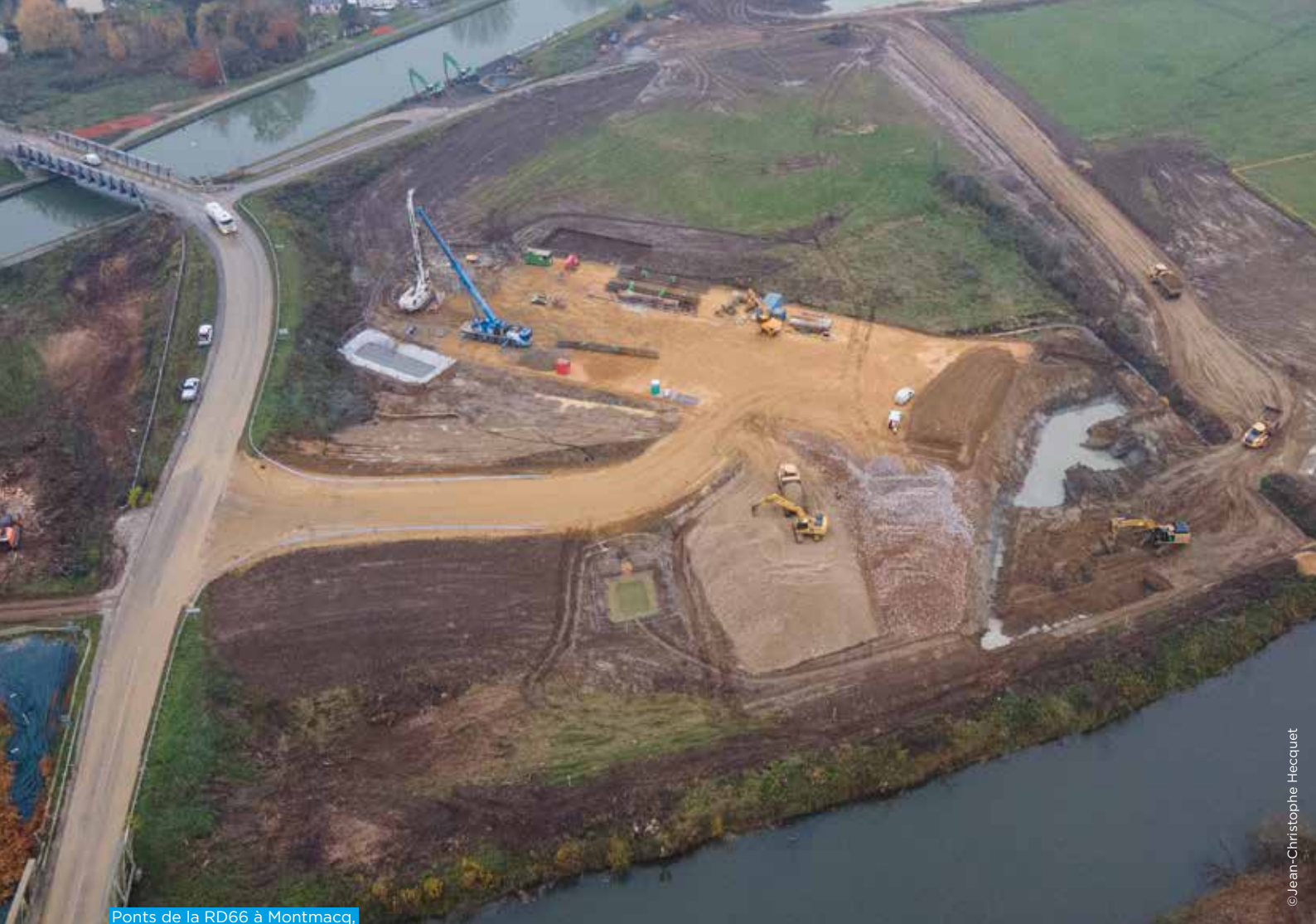
Ponts de la RD66 à Montmacq, Oise
