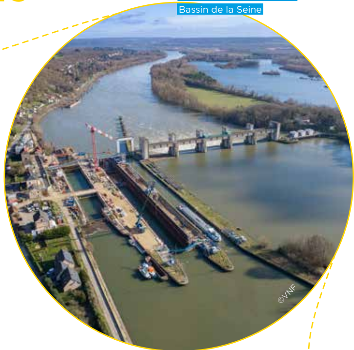
Les écluses de Méricourt, Bassin de la Seine
