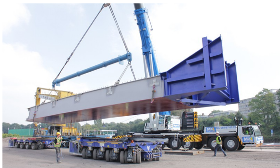
Livraison des caissons formant la charpente métallique du viaduc
