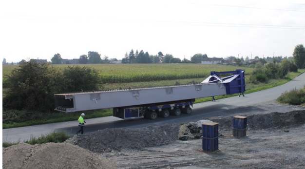
Livraison des caissons formant la charpente métallique du viaduc
