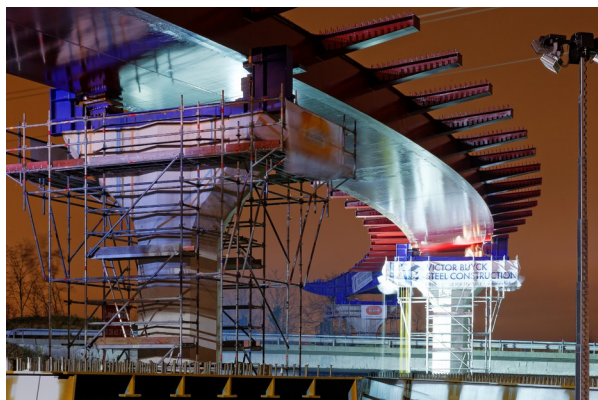
Lançage de la charpente métallique
