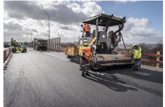
Réalisation des derniers travaux nécessaires à la réouverture de la 4 ème voie de circulation de l'A15 mi-mars .
