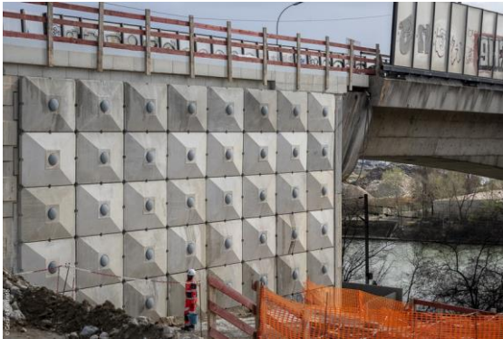
Poursuite des travaux jusqu'au confortement complet du remblai sur toute sa hauteur début mars .
