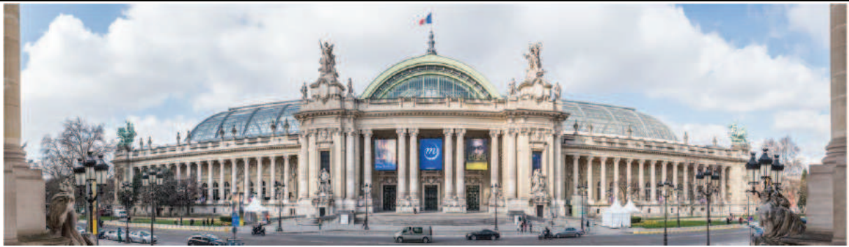
Figure 20 Avenue Winston Churchill, vue d'ensemble de la façade Est du Grand Palais, entrée de la Nef © N. Krief
