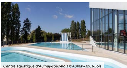
Centre aquatique d'Aulnay-sous-Bois ©Aulnay-sous-Bois
