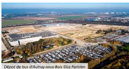
Dépôt de bus d'Aulnay-sous-Bois ©Le Parisien
