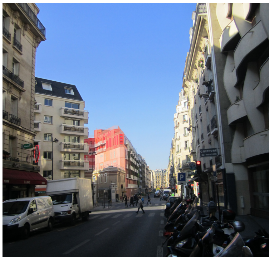
4/ VUE DU SITE DEPUIS LA DE LA CROIX-NIVERT
