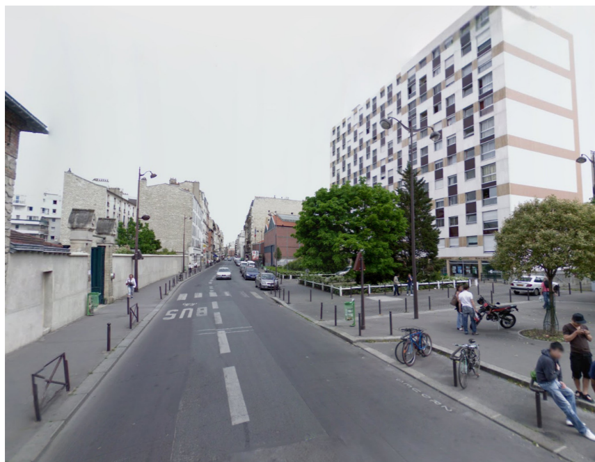
1/ VUE DU SITE DEPUIS LA RUE LECOURBE
