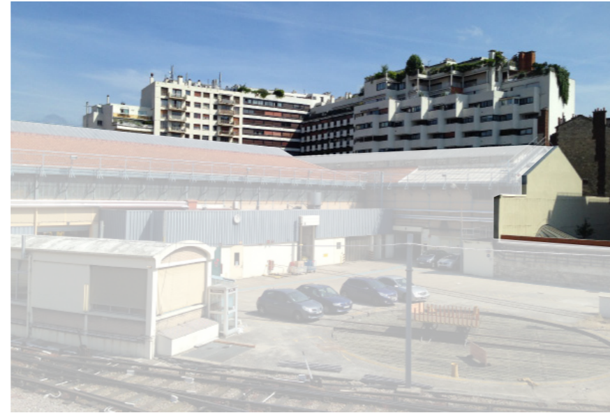
2/ VUE DU SITE RATP VERS L'IMMEUBLE SITUÉ : 283-285, RUE LECOURBE 202-204, RUE DE LA CROIX NIVERT
