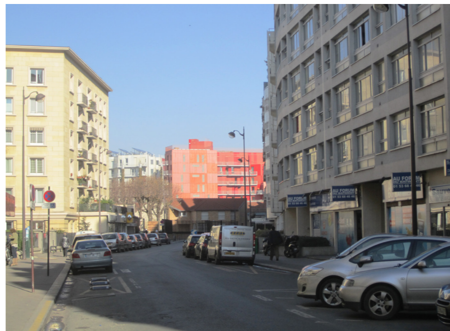
2/ VUE DU SITE DEPUIS LA RUE DESNOUETTES
