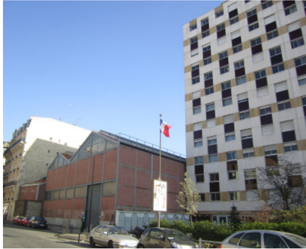
1/ RUE LECOURBE - HALLES EXISTANTES
