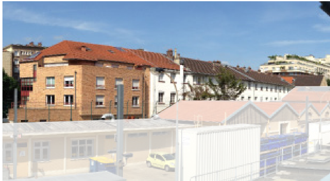
4/ VUE DU SITE RATP VERS LA CONGREGATION SITUÉE : 56-58, RUE DESNOUETTES
