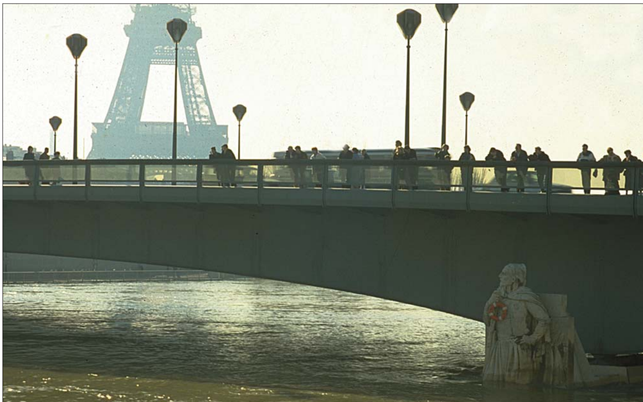
Inondation de la Seine à Paris - Pont de l'Alma - 01/02/1990
