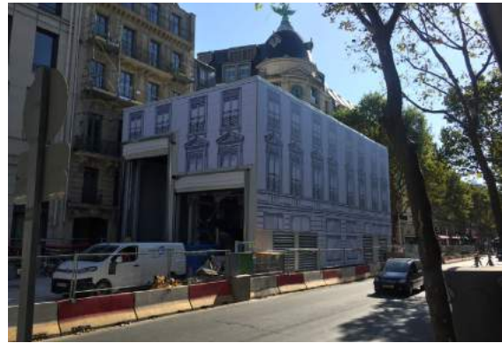
Hangar Acoustique Boulevard Haussmann
