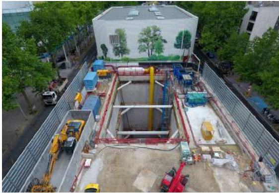
Hangar Acoustique Courbevoie
