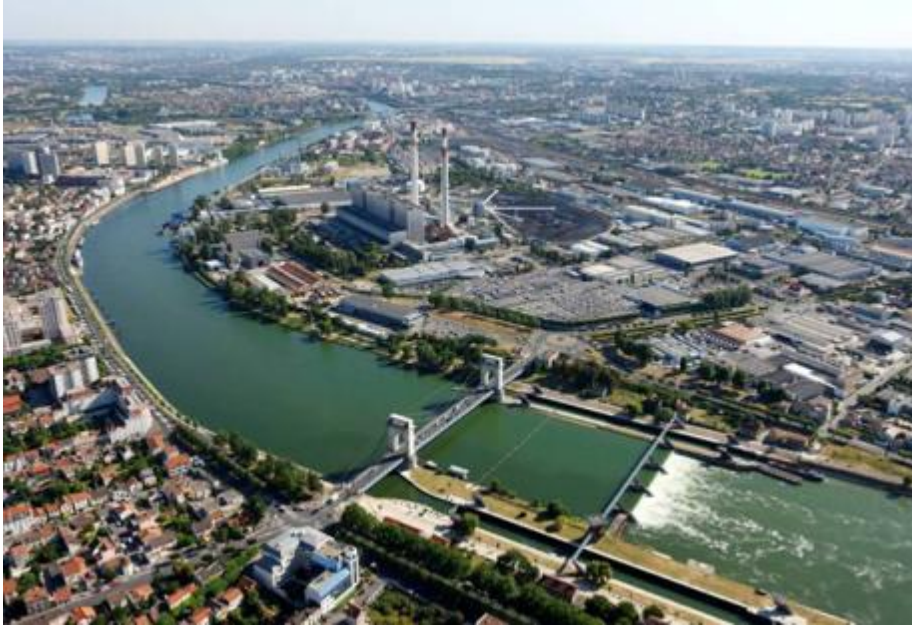
La centrale électrique au cœur des Ardoines
