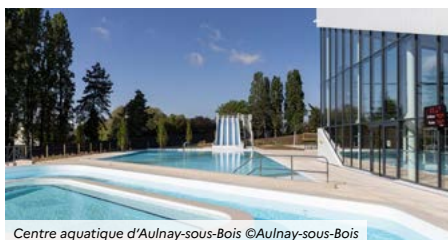
Centre aquatique d'Aulnay-sous-Bois ©Aulnay-sous-Bois
