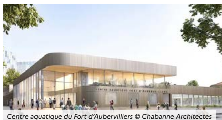
Centre aquatique du Fort d'Aubervilliers © Chabanne Architectes
