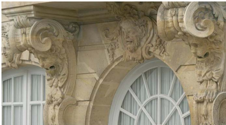
Détail de la façade de l'hôtel de Noirmoutier © DR
