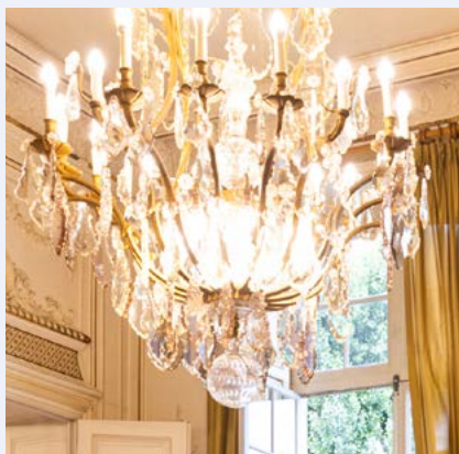
Lustre utilisant des ampoules bases tension © SRCI
