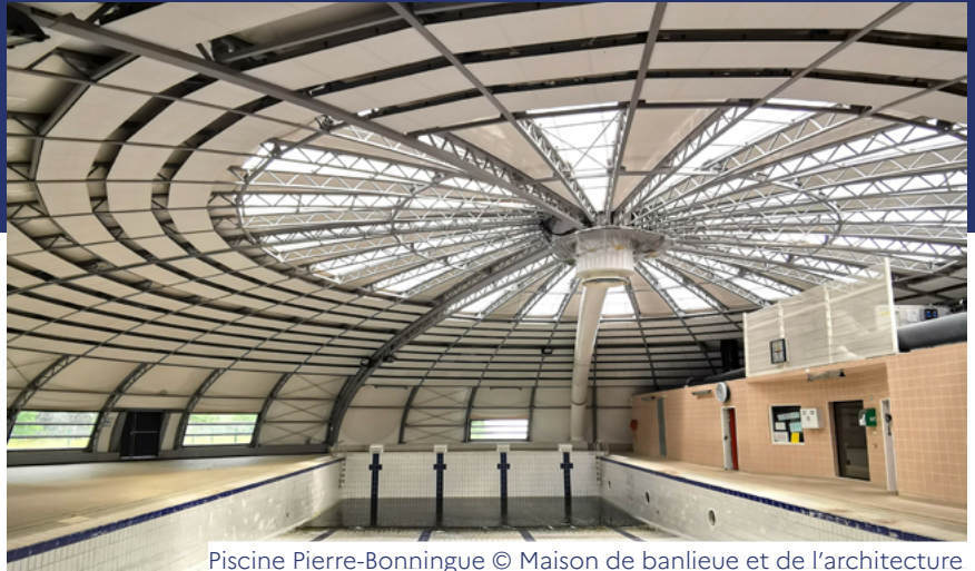
Piscine Pierre-Bonningue © Maison de banlieue et de l'architecture
