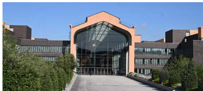
Entrée de la cafétéria du Village Olympique ©SRCI
