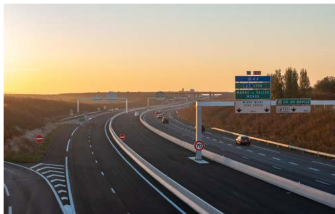
Contournement Est de Roissy ©VINCI Construction France
