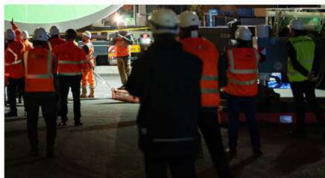
Inspection du chantier de la Tour Eiffel ©DRIEETS
