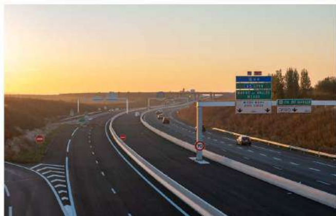
Contournement Est de Roissy ©VINCI Construction France
