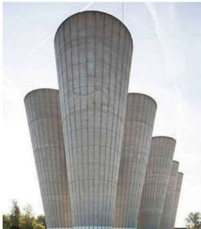
Villejuif, Réservoirs d'eau dits « Les Flûtes » ©Olivier Mathiotte, La Manufacture du Patrimoine – DRAC Île-de-France
