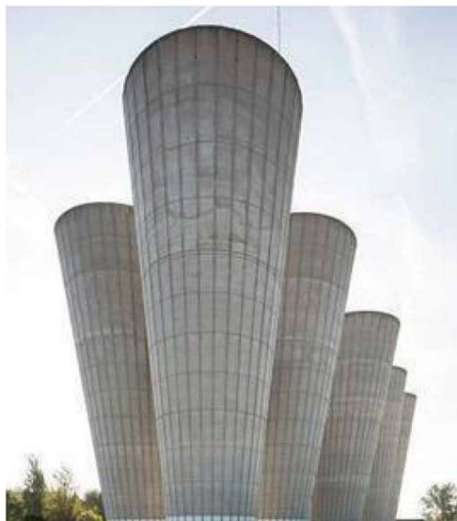
Villejuif, Réservoirs d'eau dits « Les Flûtes » ©Olivier Mathiotte, La Manufacture du Patrimoine – DRAC Île-de-France
