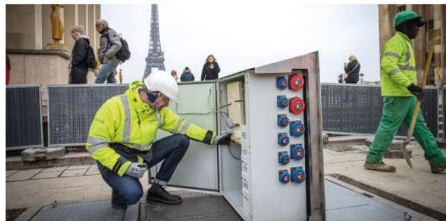
Borne électrique rétractable pérenne ©Enedis
