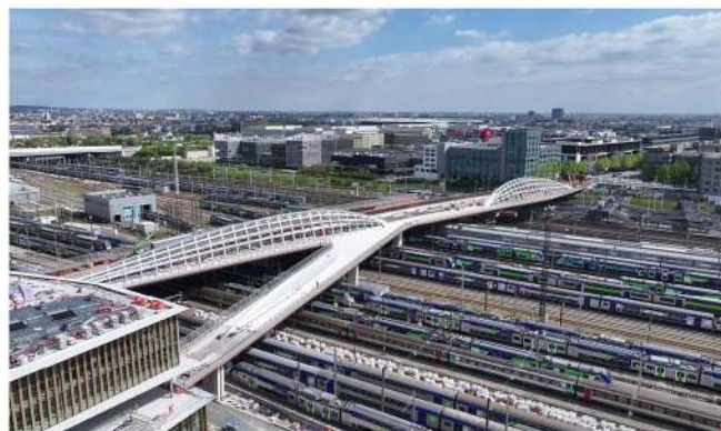
Le Franchissement Urbain Pleyel © SPL Plaine Commune Développement / Franck Badaire
