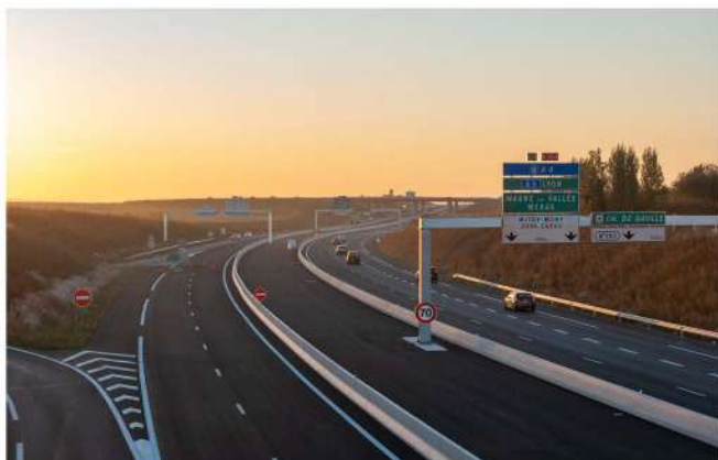
Contournement Est de Roissy ©VINCI Construction France
