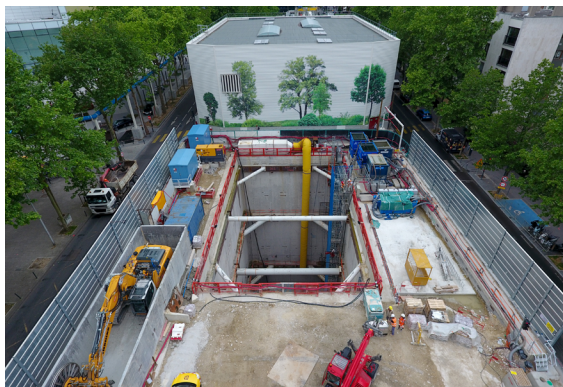
Hangar Acoustique Courbevoie
