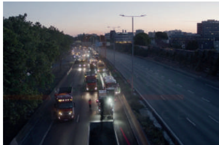
Rénovation des chaussées de l'autoroute A1
