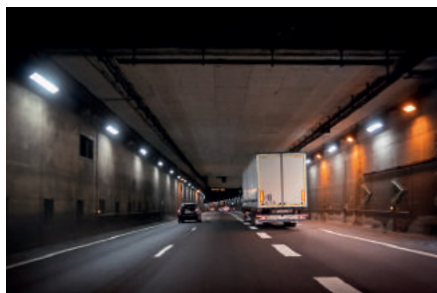
Tunnel de Nogent, sur l'A86
