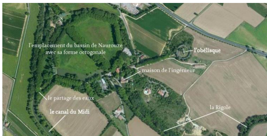
Figure 54 : Bassin et seuil de Naurouze. Source : Belcaire Pyrénées
