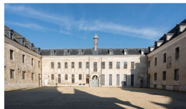
La cour d'honneur avec à gauche l'aile d'Estouville et en face l'aile Nord, destinées à accueillir le conservatoire et l'auditorium.
