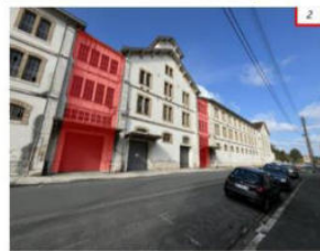
Passages traversants entièrement déconstruits
