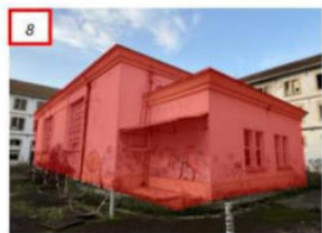
Déconstruction bâtiment chaufferie
