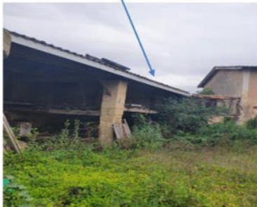
Bâtiment dépendances (démolitions)
