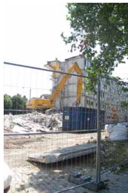
Bourtzwiller – Démolition des 420
