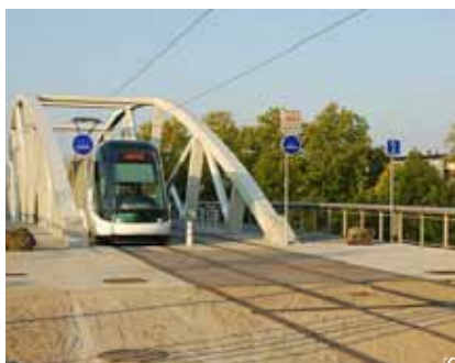
Montagne-Verte – Nouvelle passerelle piétons-tramway
