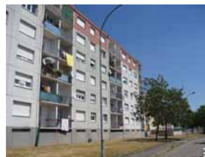
La Thur et Markstein– logements sociaux
