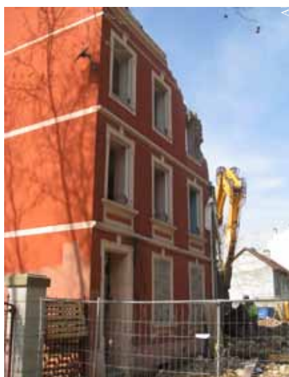
Wolf-Wagner-Vauban-Neppert– Démolition d'immeuble rue des Chaudronniers
