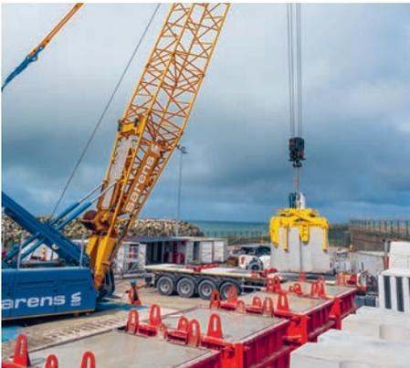
Fabrication des blocs cubiques rainurés.
