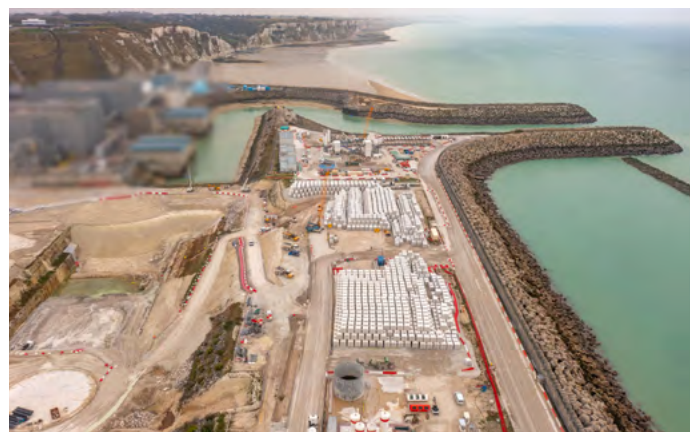
Les travaux préparatoires du chantier de l'EPR 2 à Penly (Seine-Maritime)
