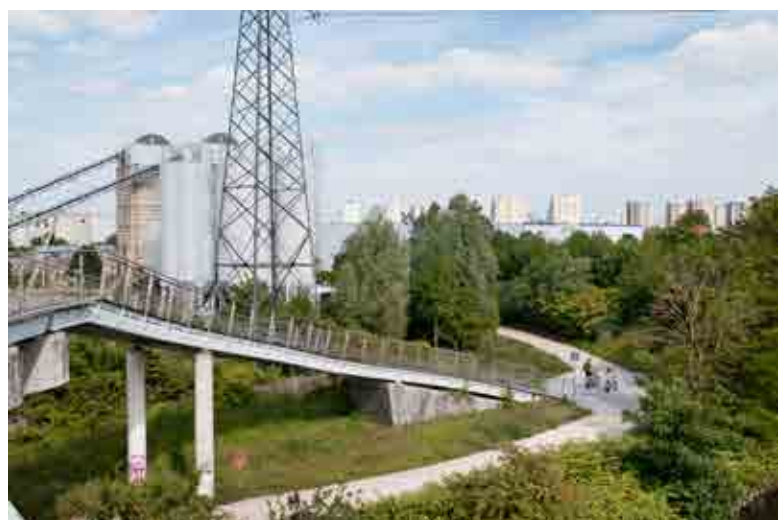
Nanterre, passerelle enjambant l'entrée du port industriel Crédit photo : © Ambroise Tézenas et Jémémie Léon. OPP de la vallée de la Seine francilien.
