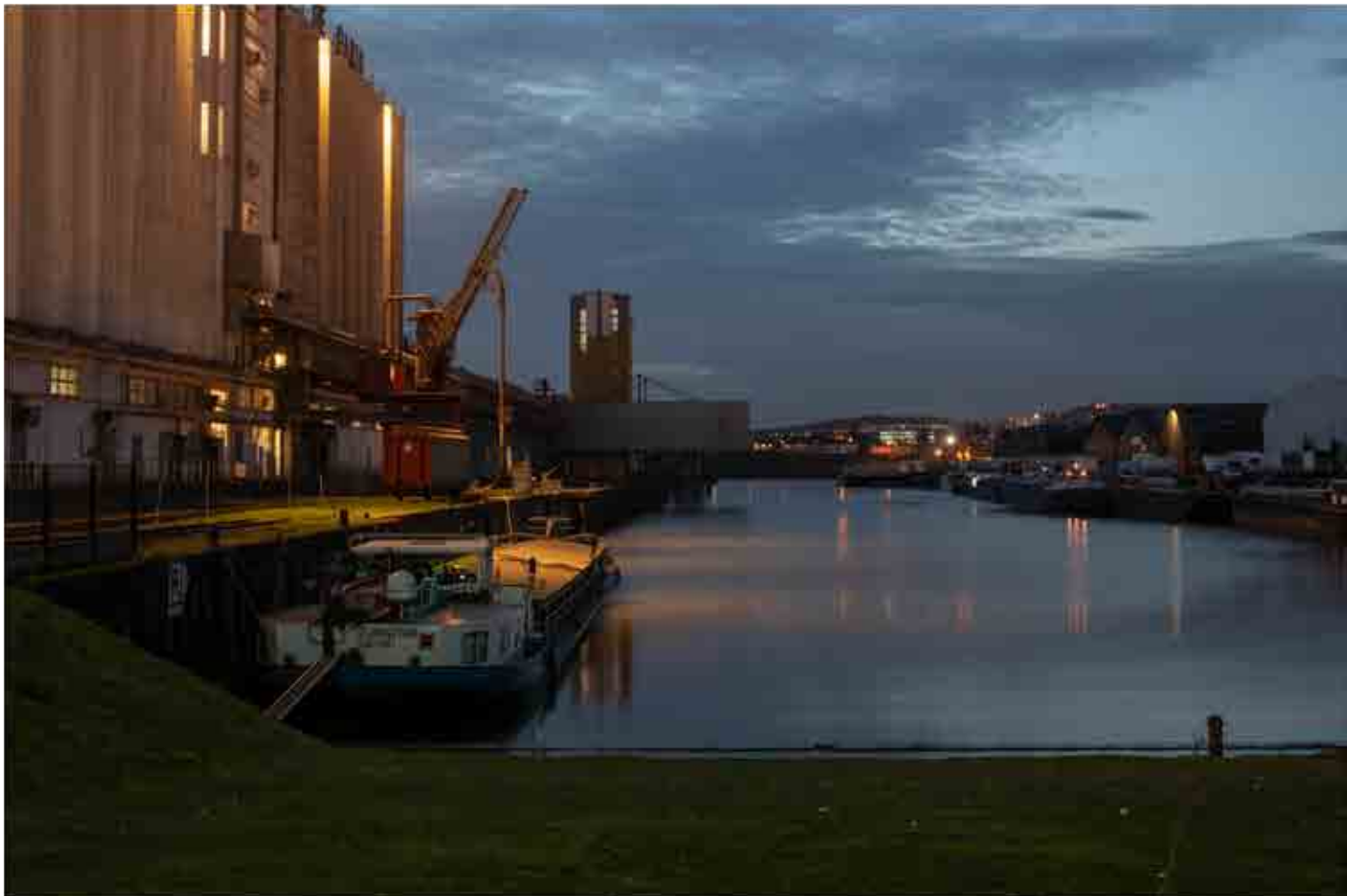
Gennevilliers, port, darse n°2 Crédit photo : © Ambroise Tézenas et Jémémie Léon. OPP de la vallée de la Seine francilien.
