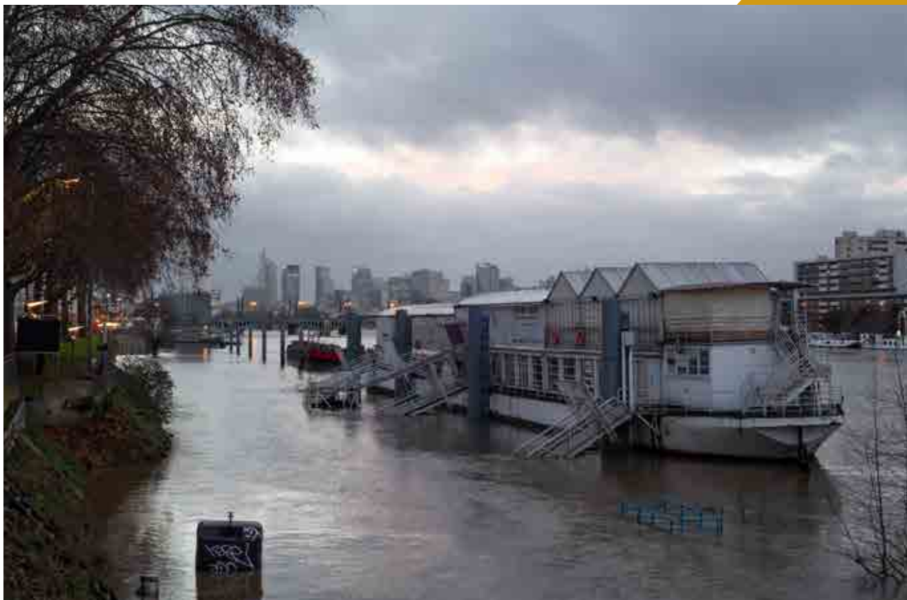
Clichy-la-Garenne, berge inondée en contrebas du quai de Clichy Crédit photo : © Ambroise Tézenas et Jémémie Léon. OPP de la vallée de la Seine francilien.
