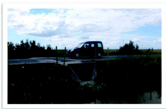
Figure n° 151 : Passage busé sous la route à Champagné-les-Marais ©PNR Marais poitevin
