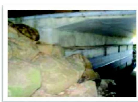
Figure n° 152 : Encorbellement (passage à sec sous un pont)
