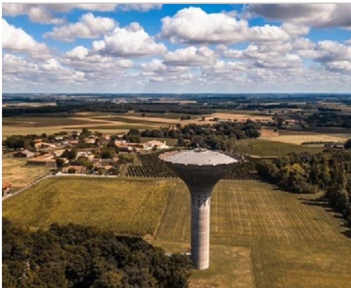
Château d'eau d'Asnières-la-Giraud (17)
