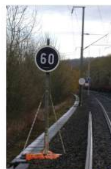
Limitations temporaires de vitesse en cas de canicule ou d'inondation pour éviter un incident (voie ou caténaire)
