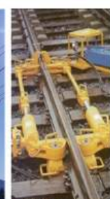
Possibilité de changer le réglage du rail pour être plus résilient à la chaleur (mais moins au froid)
