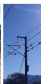
Projet pilote : caténaire « CS2R » 1500 V plus résiliente aux fortes chaleurs
