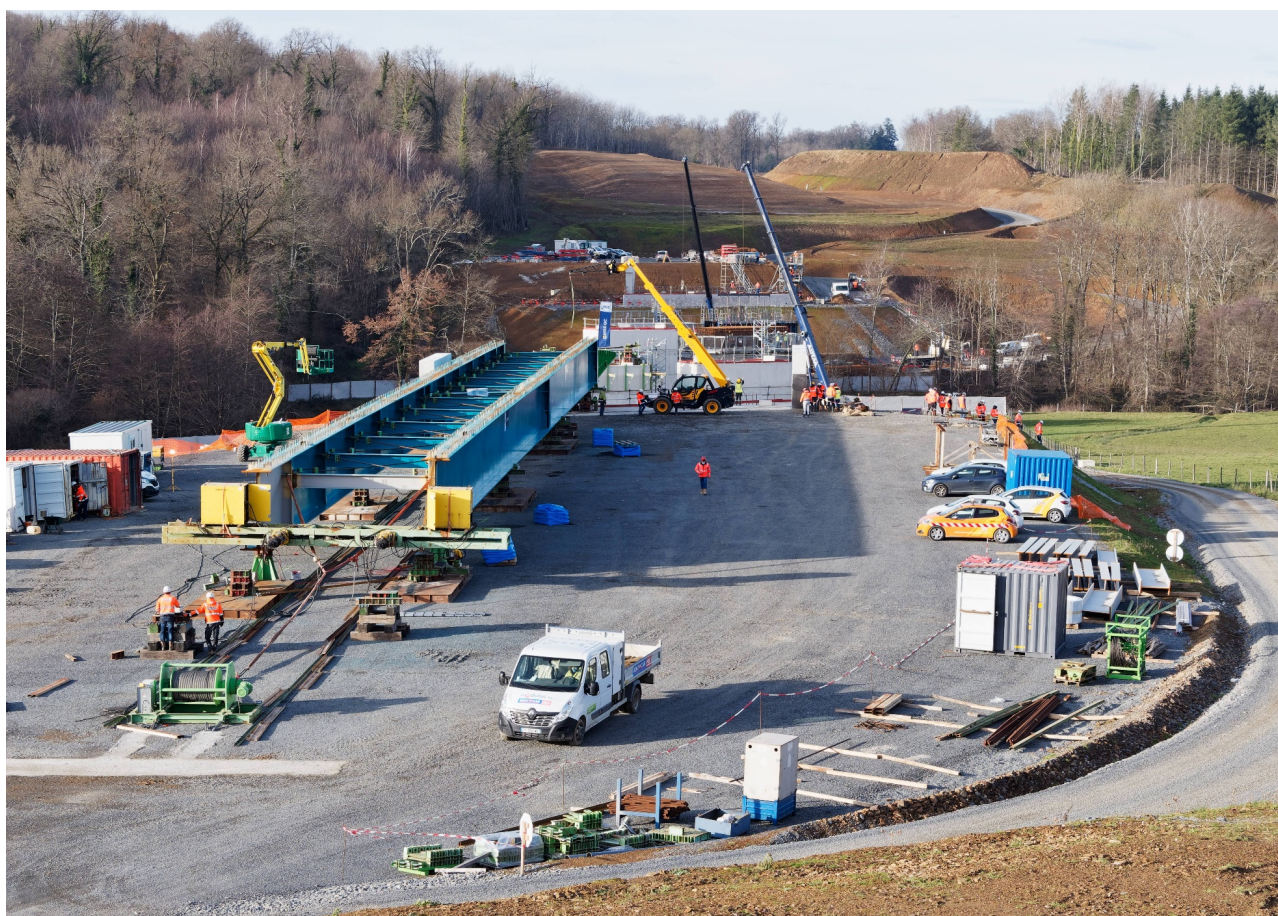
Ci-dessus et page suivante : construction du viaduc sur la Charente. crédit photo: Thierry DEGEN, DREAL Nouvelle-Aquitaine
