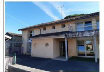
Façade avec accès rue Sainte Catherine
