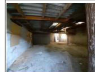
Intérieur brut toit en tôles sol ciment pour partie
