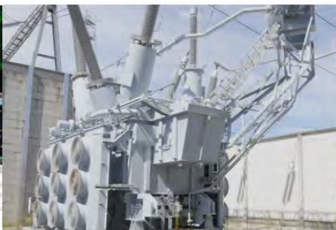
Ajout de transformateurs pour modifier la capacité d'un poste
