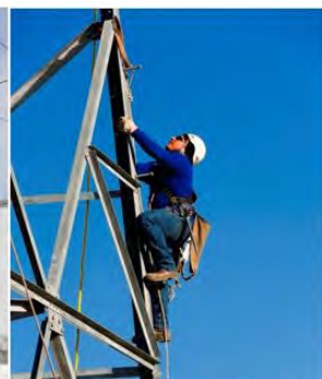
Travaux pour augmenter la capacité d'une ligne
