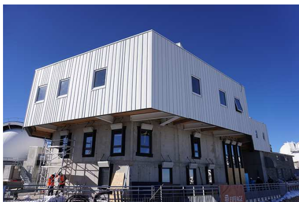
Le clos couvert de la structure "Dauzère-Soler"
