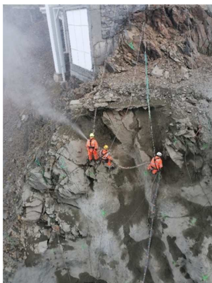
Travaux de renforcement de la falaise
