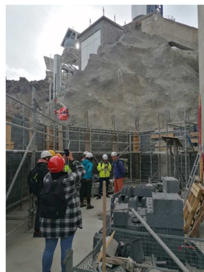
Travaux sur la structure du télescope Bernard Lyot.
