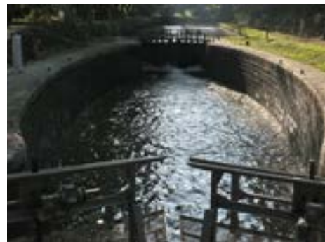
Une écluse-type du Canal du Midi
