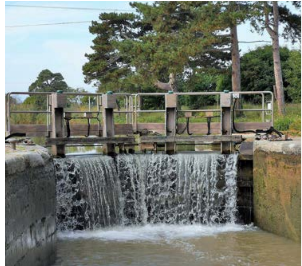
Portes amont de l'écluse d'Ognon
