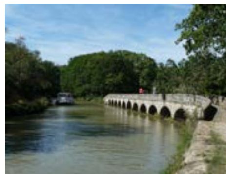
L'aqueduc de l'Argent-Double
