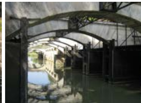
L'ouvrage du Libron
