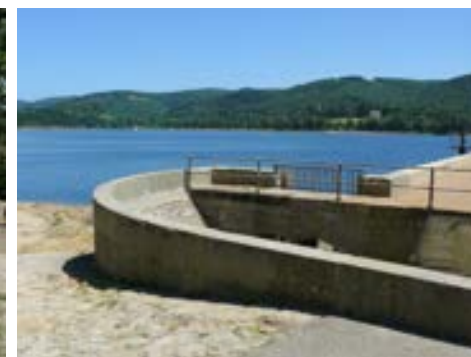
Le barrage de Saint-Ferréol
