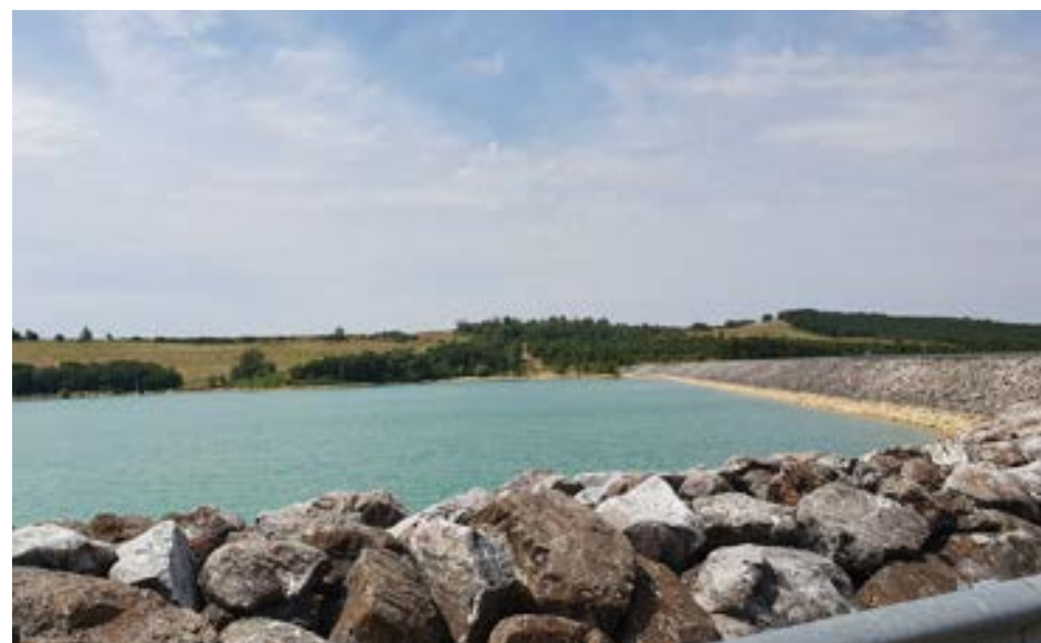
Barrage de la Ganguise Vue aérienne, 2018 - IGN/Géoportail, et vue de la retenue d'eau, 2019
