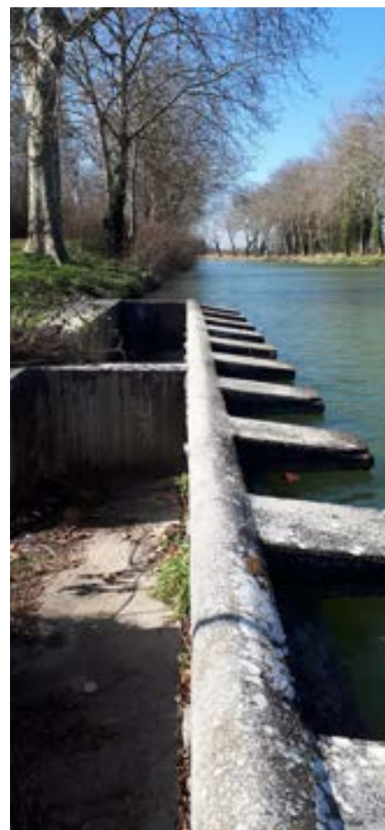
Lavoir du bief de Villepinte VNF
