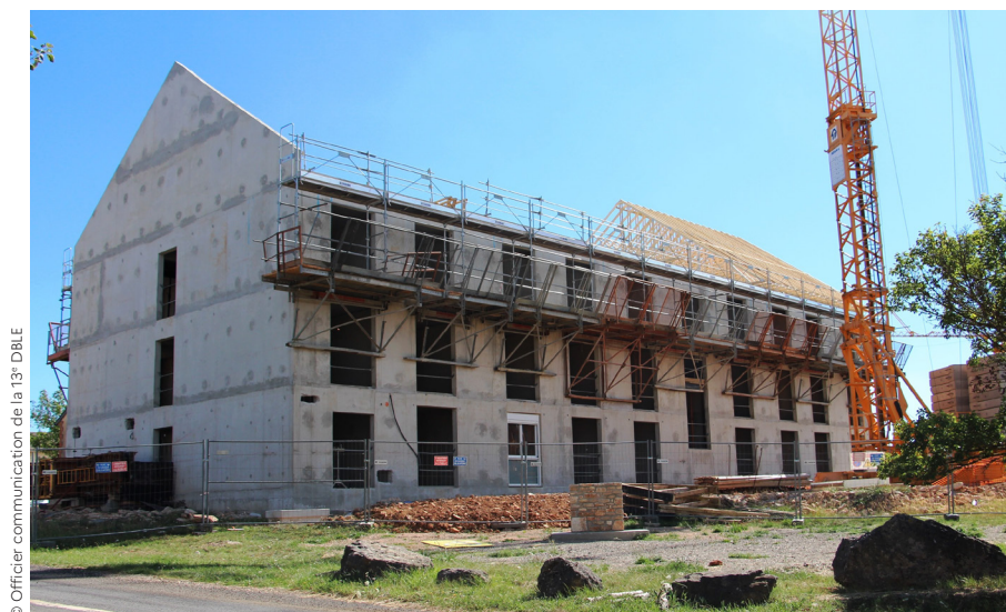
Installation de la 13 e DBLE la Cavalerie – construction d'un bâtiment de vie
